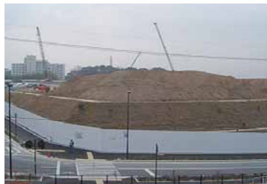
掘削した残土の一部（埋め戻しに使用）
