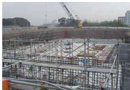
コンクリート打設部分
