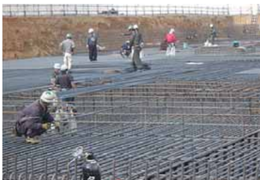
配筋工事の状況
